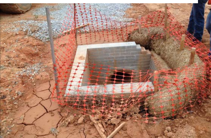
Priority 1—Type F Used in Lieu of Type A
