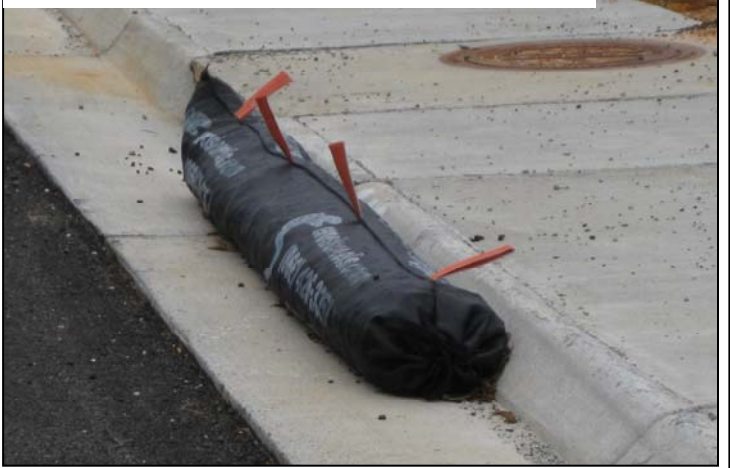
Priority 1—Type F Used in Lieu of Type A
